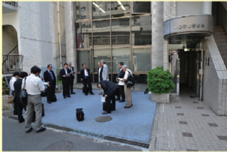
ビル正面の駐車場に8本(深度75m)の地中熱交換器を設置
