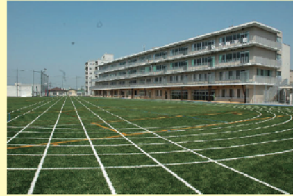
校舎に沿って40本(深度100m)の地中熱交換器を設置
